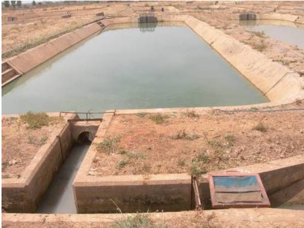
Figure 5 : Etangs de pisciculture intensive de plus de 500 m 2 au Centre d'Élevage Piscicole de Bagré, construits grâce à l'appui technique de la République de Chine Taïwan, sont très modernes. (Photo Kabré, 2006)
