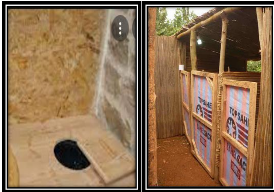
Photo 2 : Extérieure et intérieure d'une toilette sèche
