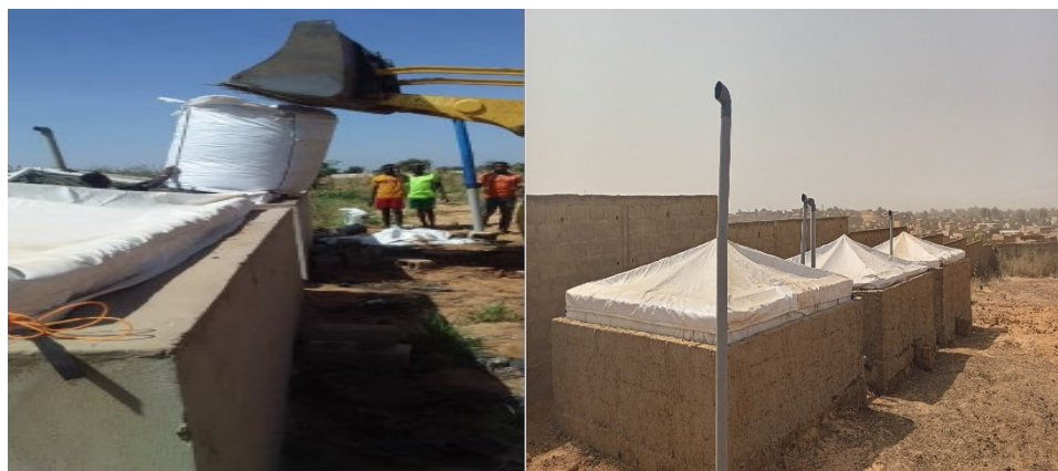
Figure 1 : Chargement du composteur CAGC (à gauche), Composteur chargé (à droite)
